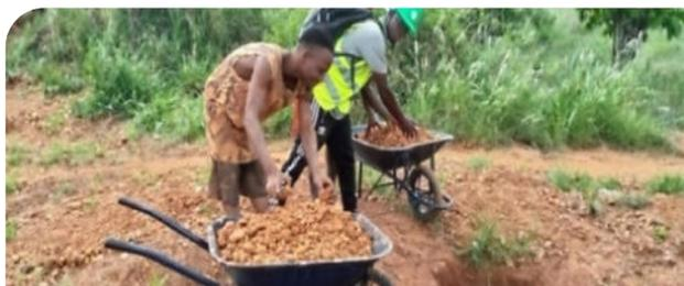
Figure 19 : Remblayage des fosses par des pierres ou blocs de roche (AEIE, 2021)
