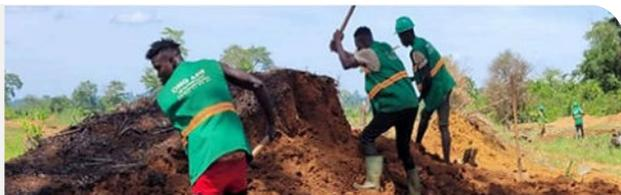
Figure 20 : Terre utilisée pour remblayer des fosses (AEIE, 2021)
